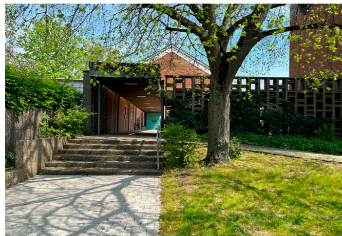
Zugang zur Zentralen Anlaufstelle von der Glogauer Straße aus über Treppen oder seitlich über die Rampe. Der Eingang zum Kirchenraum ist am Ende des Ganges.
